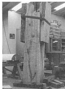
③心材と脇材を仮組みしている所。
