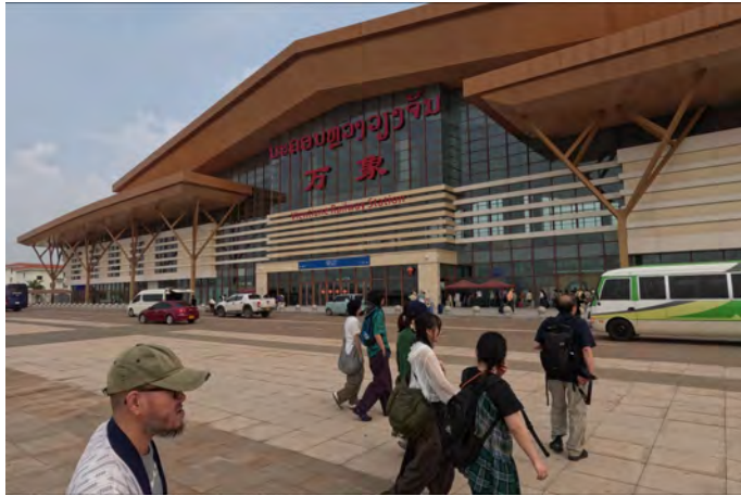
ビエンチャン駅：2021年に国内鉄道が始めて開業した。一帯一路に基づいて計画された中国式の鉄道。
