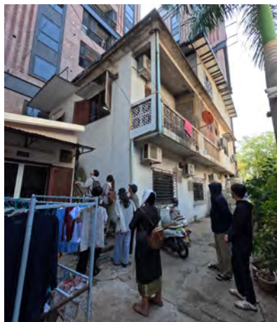
戸建住宅：もともとクリニックとしても利用されていた。
